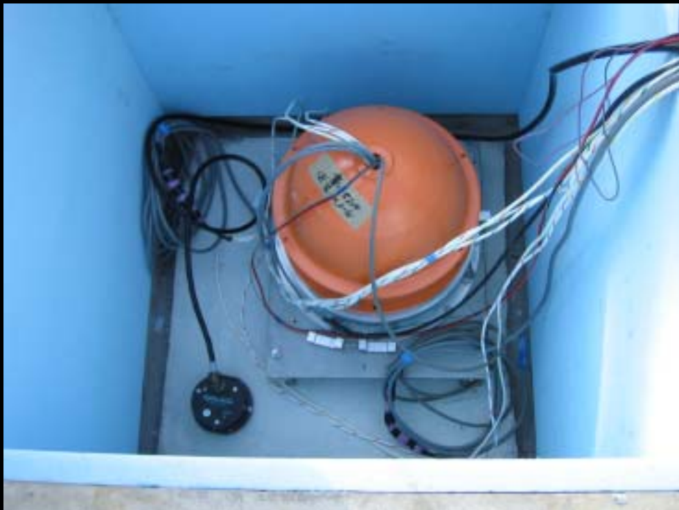
観測ピットに設置したセンサ収納容器 左下は床上に設置したEpiSensor
