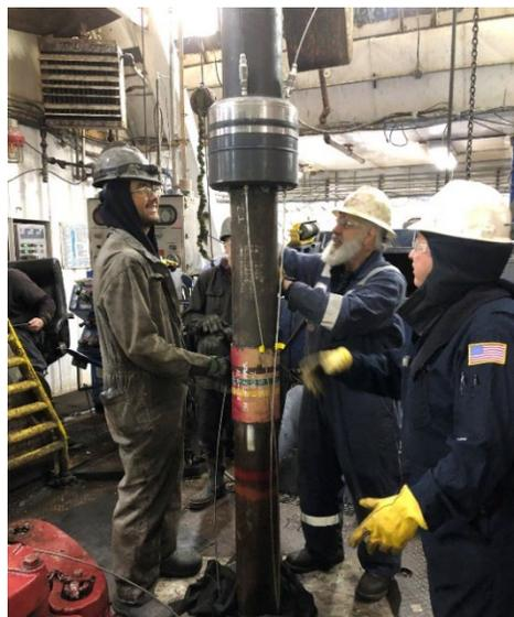
センサーケーブルの設置作業
