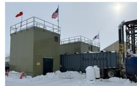
ガス産出試験中の現場（2024年4月撮影）
