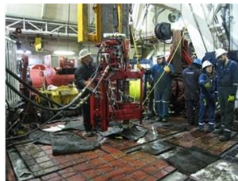
試掘井へのモニタリングケーブル設置
